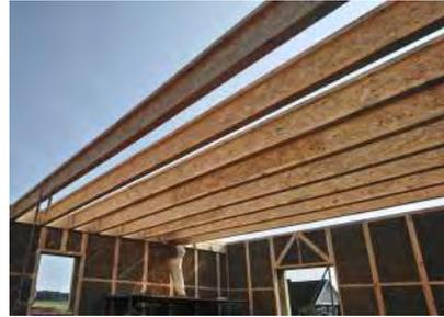
Der hölzerne I-Balken ist das tragende Element im Sammelsystem -Schalung von monolithischen Betonböden.
